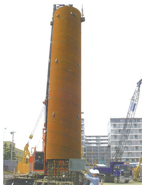
写真-1 KCTB 杭施工状況
