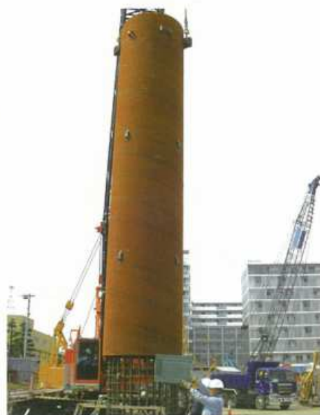
写真-1 KCTB 杭施工状況
