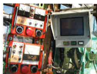
掘削攪拌機運転室
