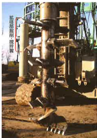
拡径部掘削・攪拌翼
