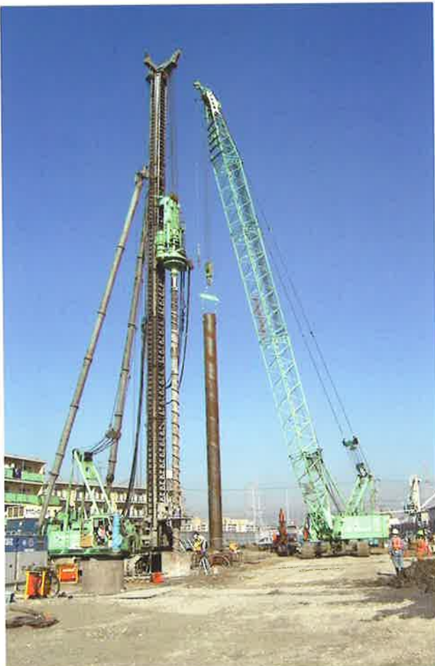
後沈設施工法全景
