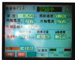
施工管理用モニターの一例
