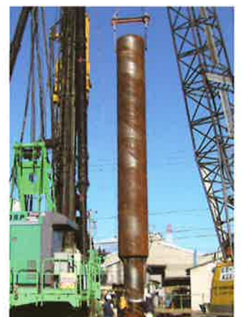
鋼管沈設
