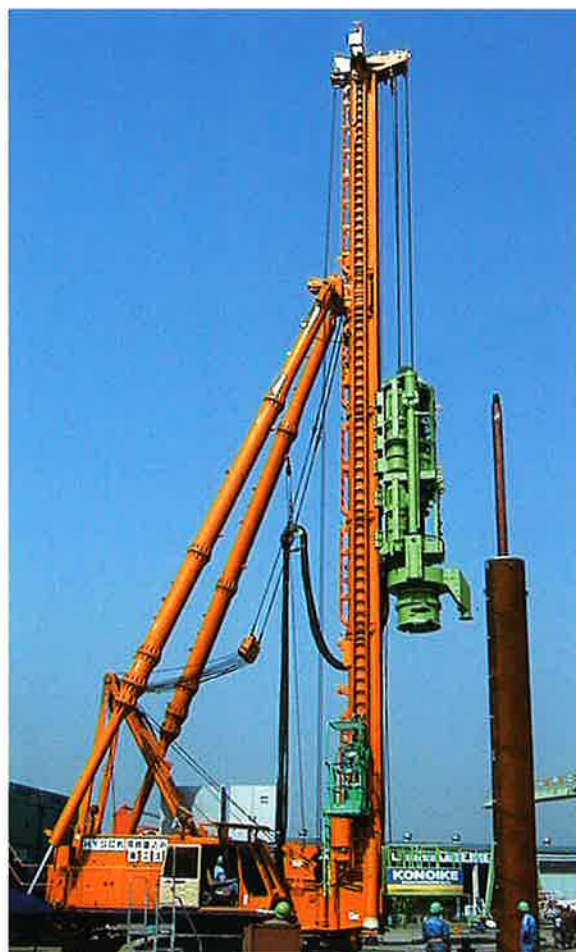
同時沈設施工法全景
