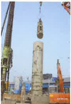
オールケーシング先行掘削
