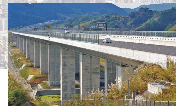
第二東名中ノ合高架橋
