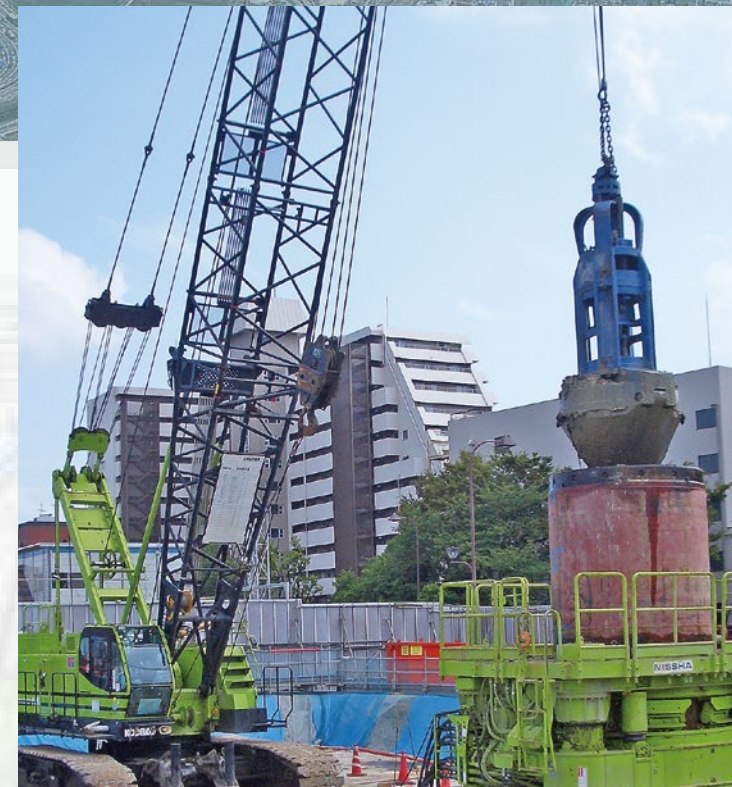
▲オールケーシング工法(全旋回工法)
