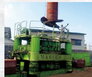
施工全景(全周回転機)
