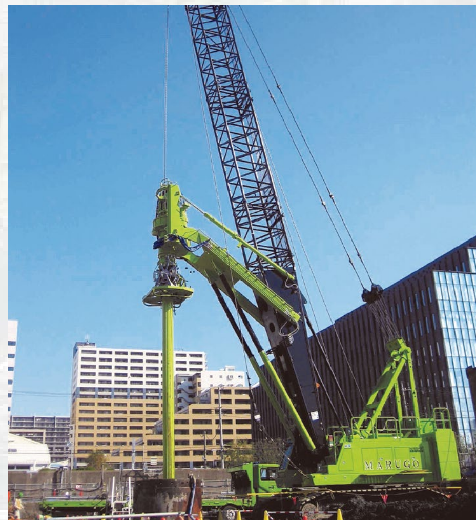
▲オールケーシング工法(全旋回工法)
