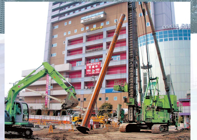
施工全景(三点式杭打ち機)
